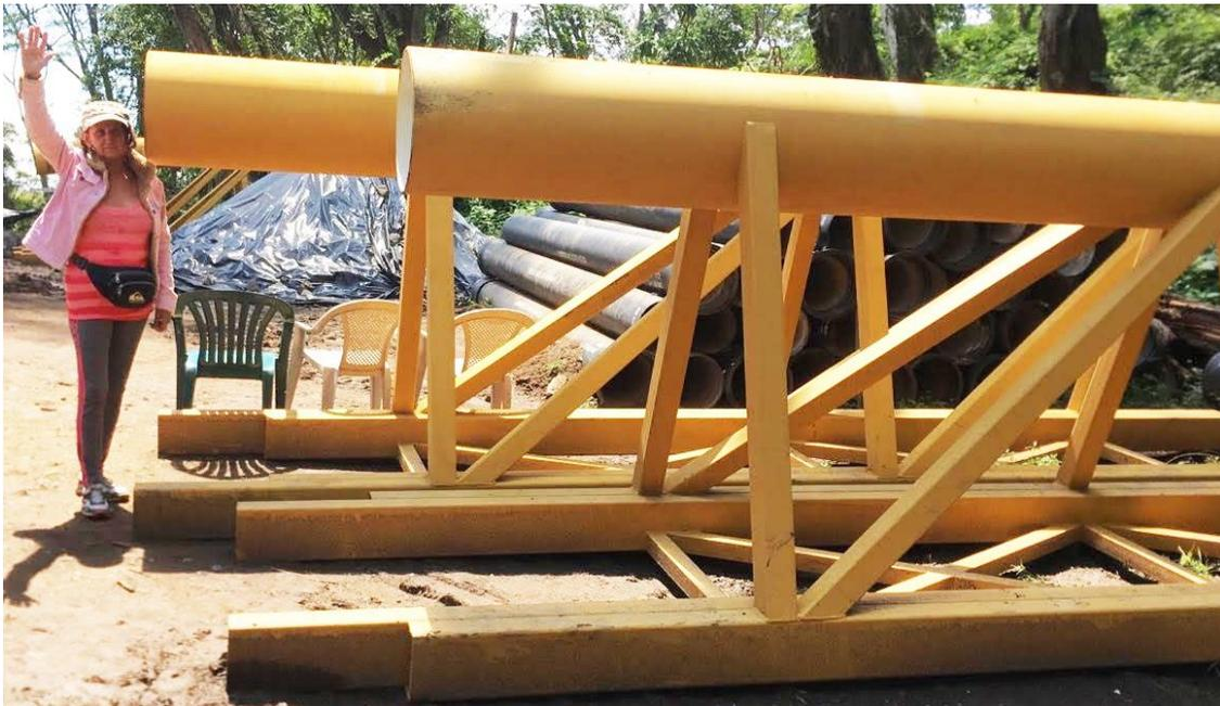
Piezas para la construcción del puente que soportará la nueva tubería. Nótese las dimensiones y por ser de metal son pesadas y necesariamente requerirán de abrir una trocha en la selva, y el uso de maquinaria pesada para llevarla hasta el lugar de destino dentro del Parque Los Chorros.
